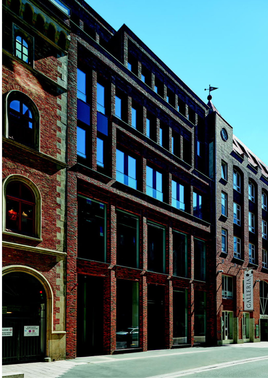
Facaden mod gaden Grosse Bleichen er udført efter samme princip som facaden mod kanalen. Søjler og dæk beklædt med mur og store vinduer, der sikrer optimalt lys i den lange bygning.
