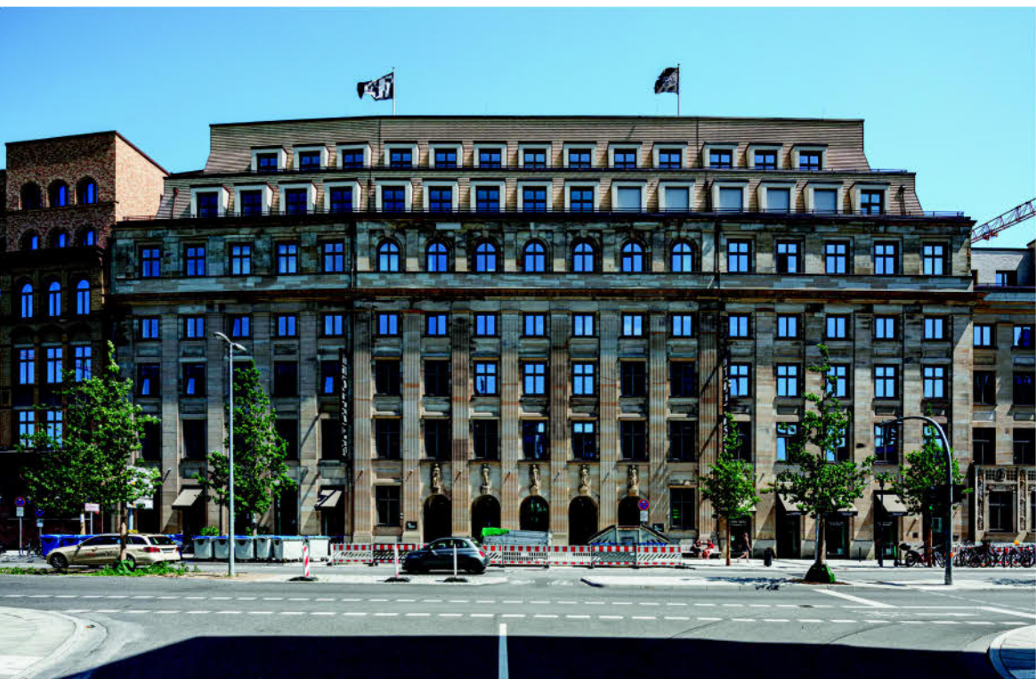
Etagetilbygningerne på Stadthaus og Brückenhaus er trukket tilbage fra facaderne og beklædt med Petersen Cover i lyse, gyldne nuancer, der genfindes i bygningens originale sandstensbeklædning.
