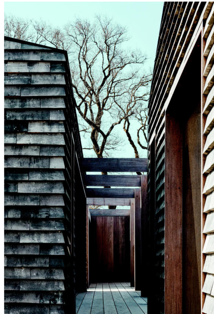
Cover er et nutidigt facademateriale, der besidder kvaliteter, der minder om de traditionelle træ-shingles. Dels i måden stenene monteres, dels i kraft af teglets levende og changerende overflade, hvor ikke to teglsten er ens.
