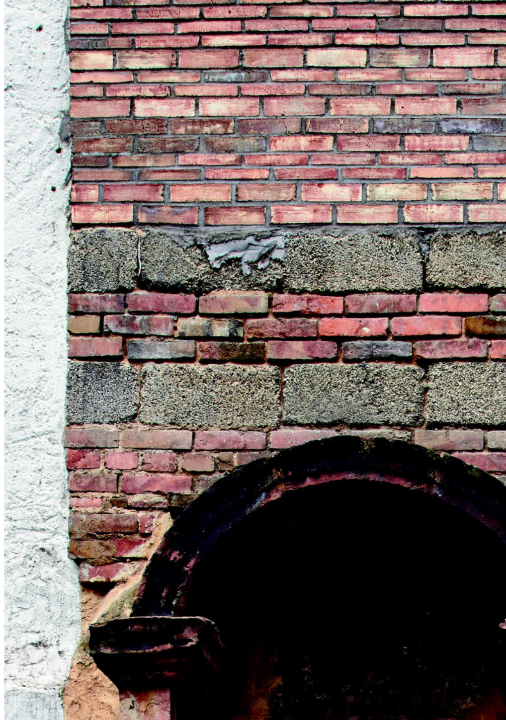
D46 i tre forskellige formater, Hamborg-format, Flensborg-format og dansk normalformat, giver stor visuel variation. Det nye murværk hviler på den oprindelige mur- og sandstensfacade.
