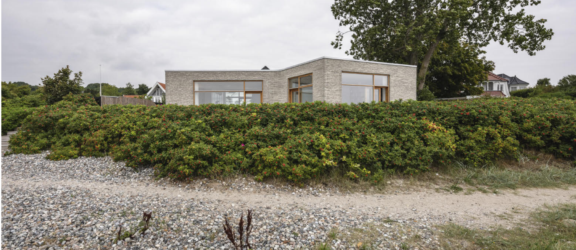
Villa Platan ligger ganske få meter fra havet lidt nord for Aarhus. Tidligt i processen tog arkitekt og bygherrer teglprøver ned til stranden for at finde den mursten, hvis grå-hvide farvespil lå tættest på nuancerne i sand og strandsten.
